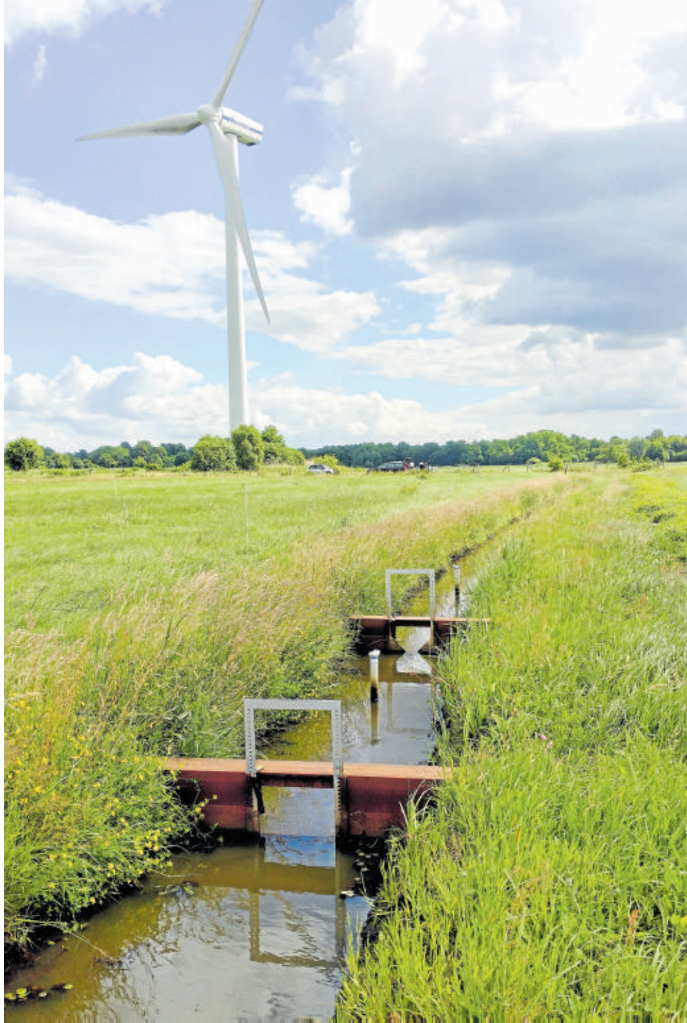
Entwässerungssysteme wie am Versuchsstandort Hammelwarder Moor könnten auch bewässern. Stauwehre könnten den Wasserstand regulieren.
