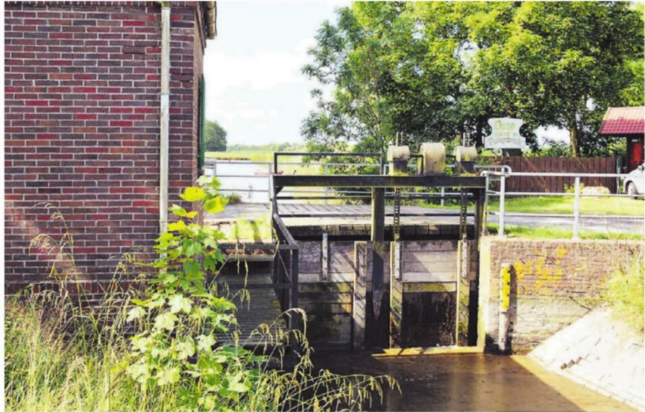
Sinnbildlich für den Wasserreichtum in der Wesermarsch stehen Schöpfwerke zur Entwässerung unter dem Meeresspiegel gelegener Flächen. Unser Bild zeigt das Schöpfwerk Mitteldeich bei Stollhamm.
